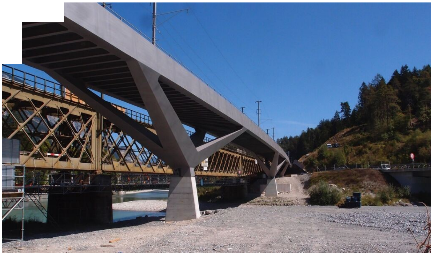
Erste Hinterrheinbrücke der Rhätischen Bahn und die neuste Fotos: Jürg Conzett
