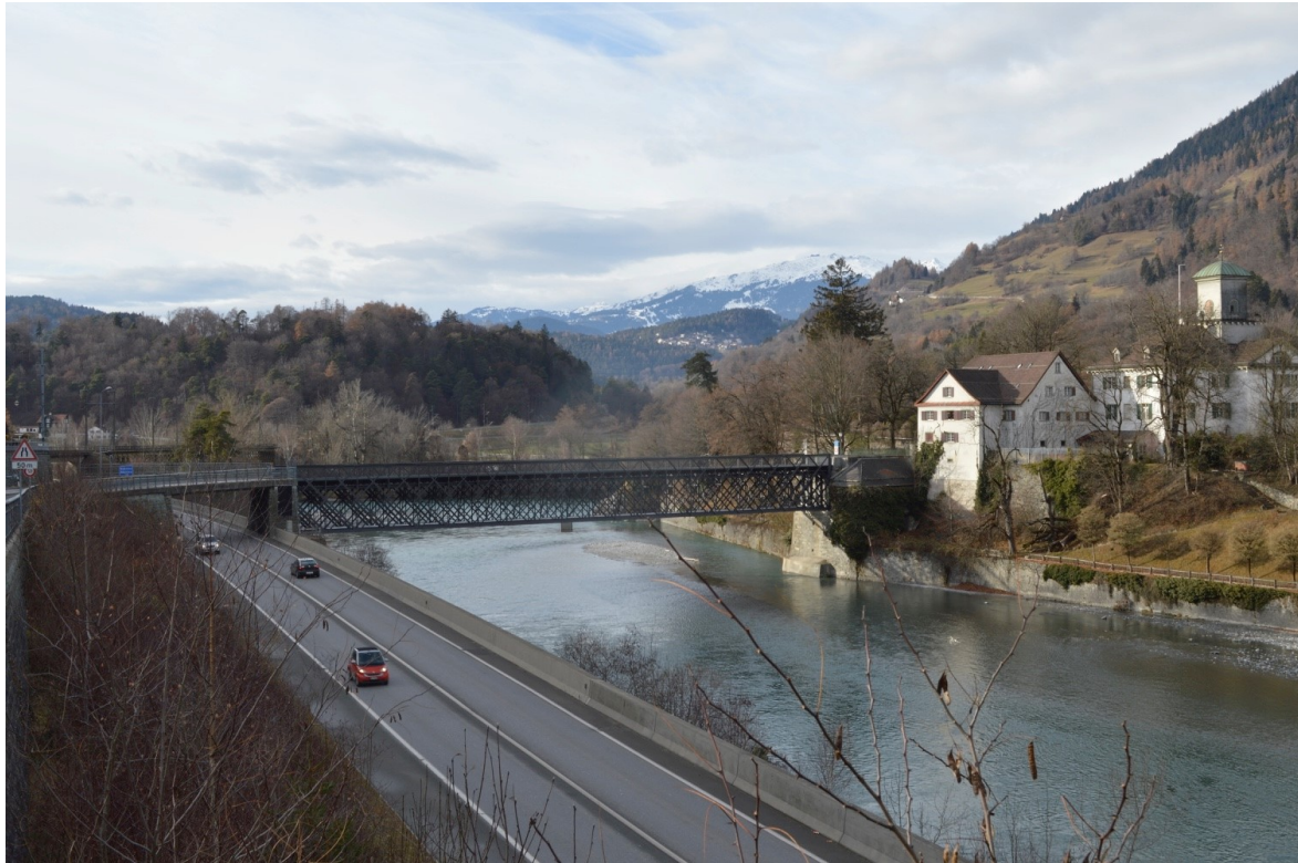
Älteste eiserne Fachwerkbrücke Graubündens
