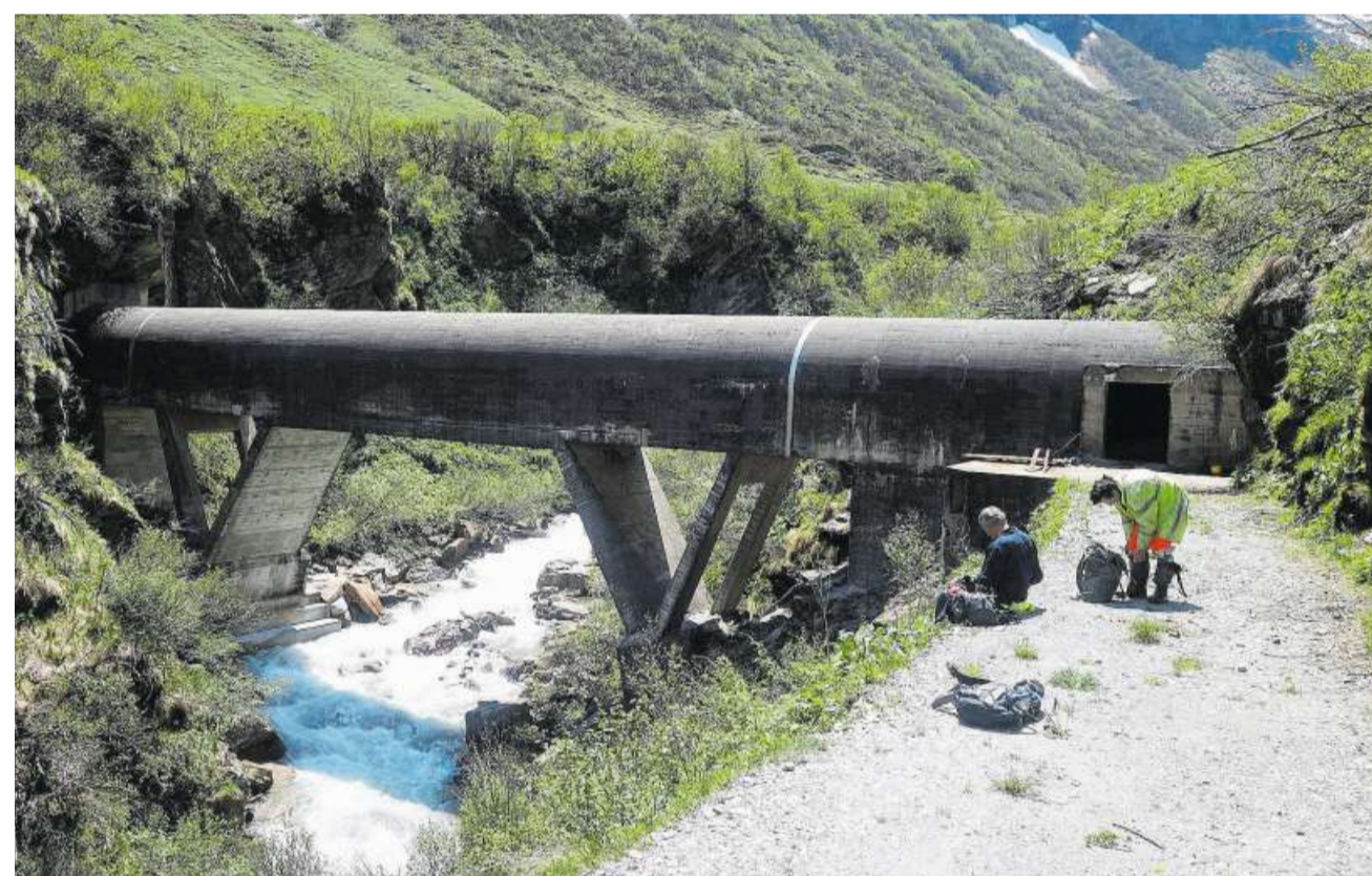
Im 14 Kilometer langen Überleitungsstollen Zervreila-Wanna fliesst das Wasser in beide Richtungen.
