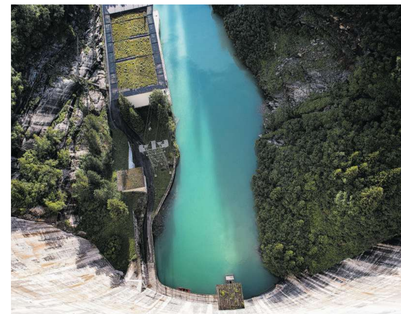
Das Ausgleichsbecken Zervreila, von der Staumauer aus 150 Metern Höhe gesehen.
