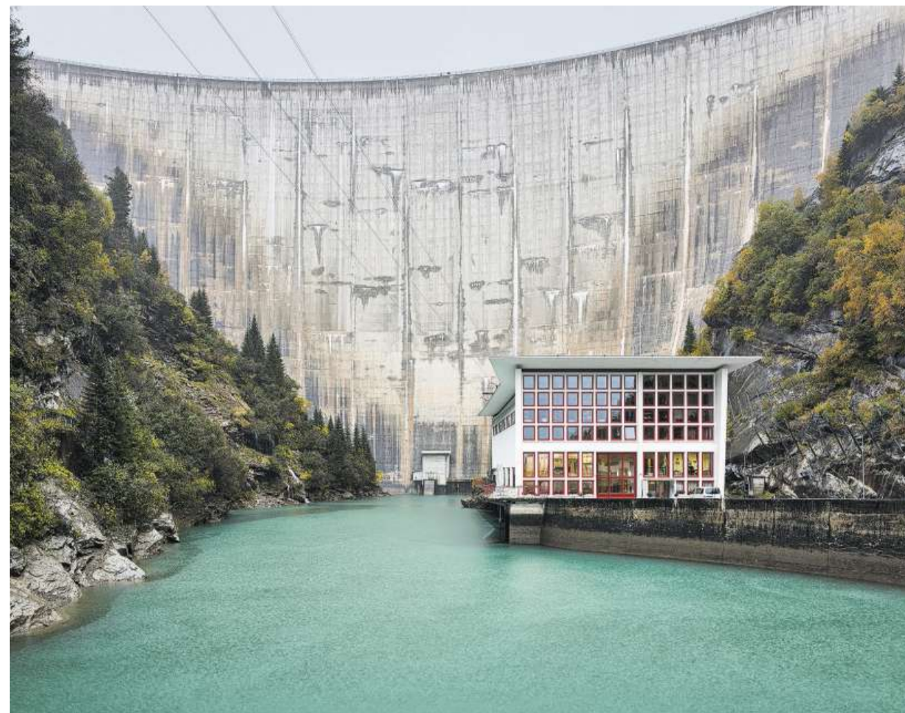
Am Fuss der Zervreila-Staumauer steht die Kraftwerkzentrale von 1958.
