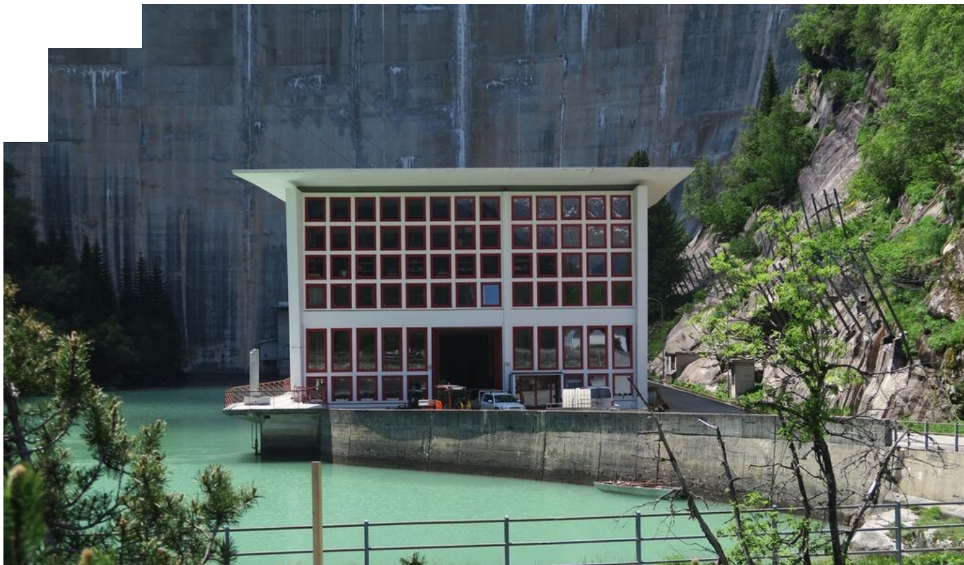
Zentrale und Ausgleichsbecken Zervreila Fotos: Ivo Bösch
